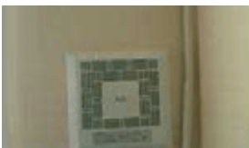
5. ติดตั้ง แผงจ่ายอากาศ
